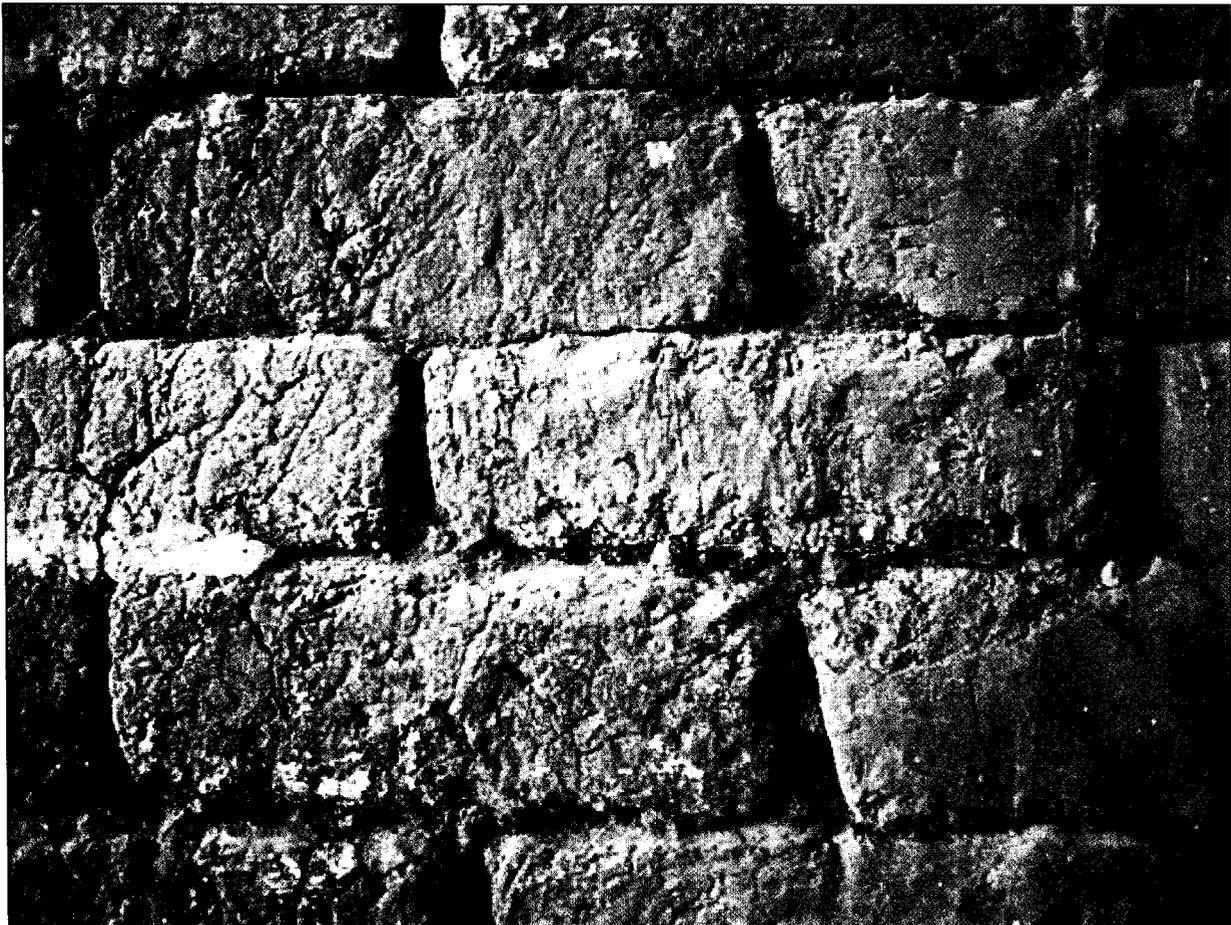
*Abb. 43: Aschkelon: Detailstruktur von ungebrannten Tonziegeln in der Stadtmauer aus kanaanitischer Zeit.*
